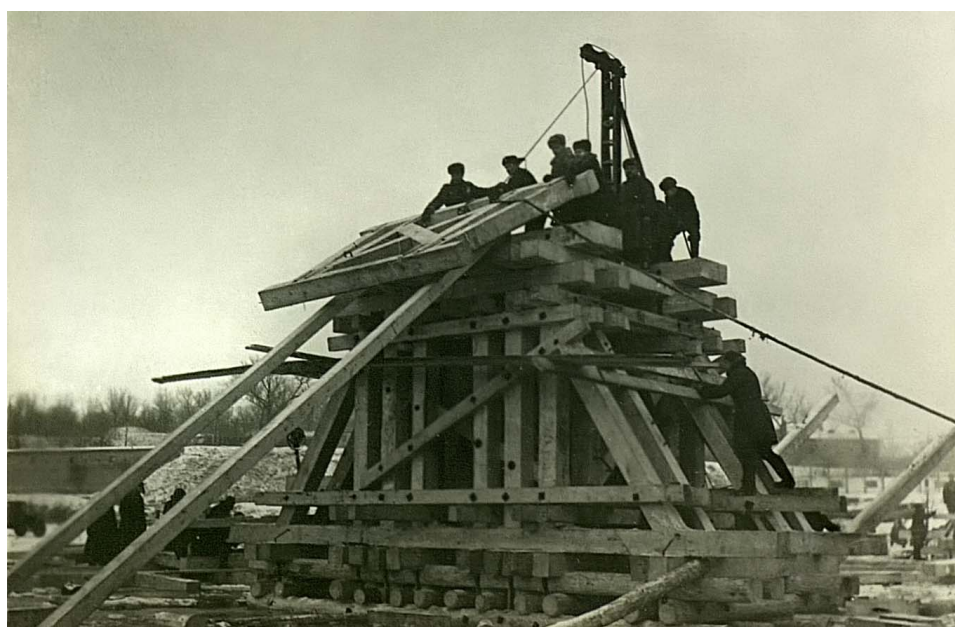
Восстановление моста через р. Нарев (Западный Буг).
