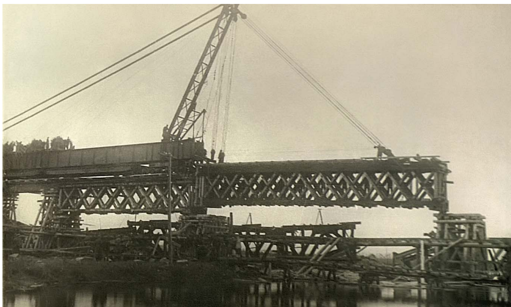
Восстановление ж.-д. моста через р. Проня.
