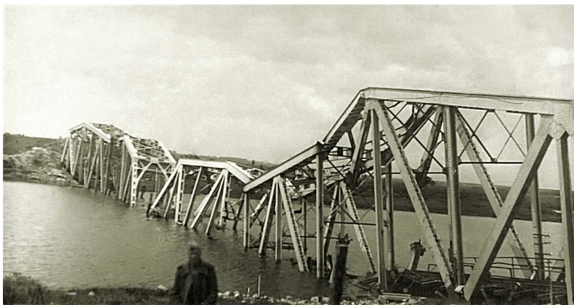
Вид ж.-д. моста через р. Проня, разрушенного противником при отступлении.
