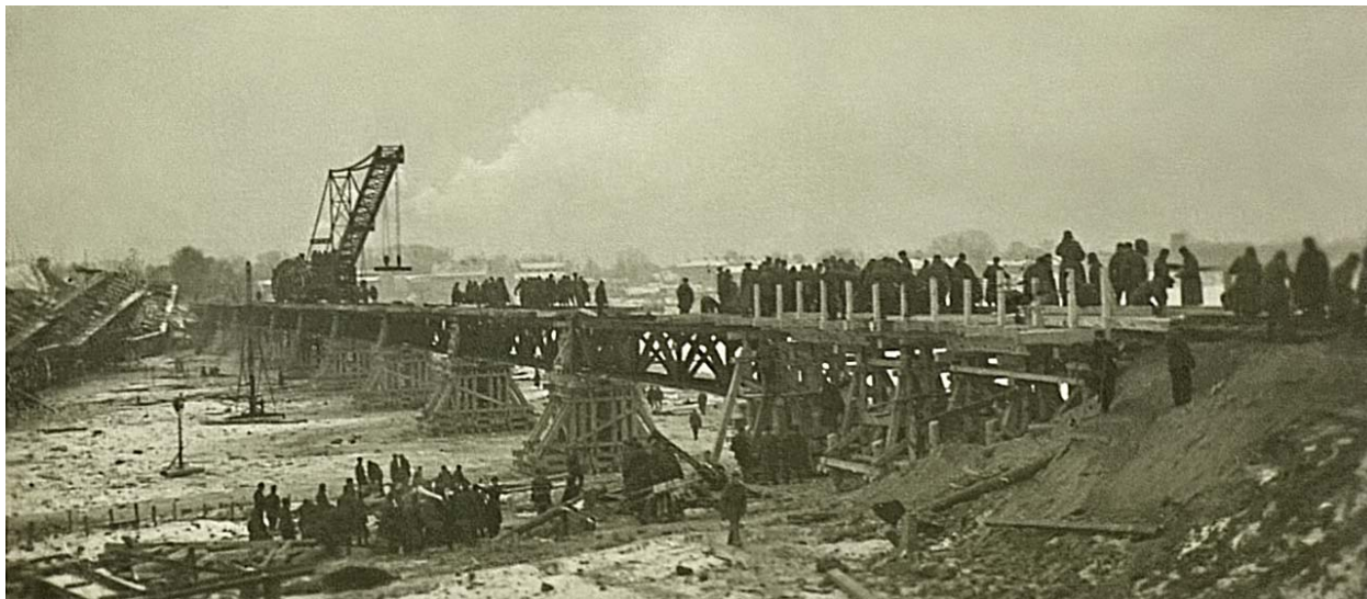
Завершающий этап работ по восстановлению моста через р. Нарев (Западный Буг).
