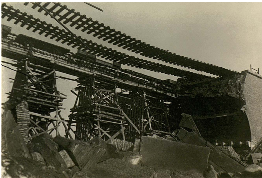
Картина разрушений и вид восстанавливаемого моста через р. Лютрыня у ст. Яблоново.
